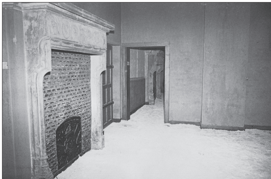
Fig. 6 – Du sable a été répandu sur les planchers pour réduire les risques d’incendie. © Ville de Liège, Grand Curtius – cliché H. van Heule.
