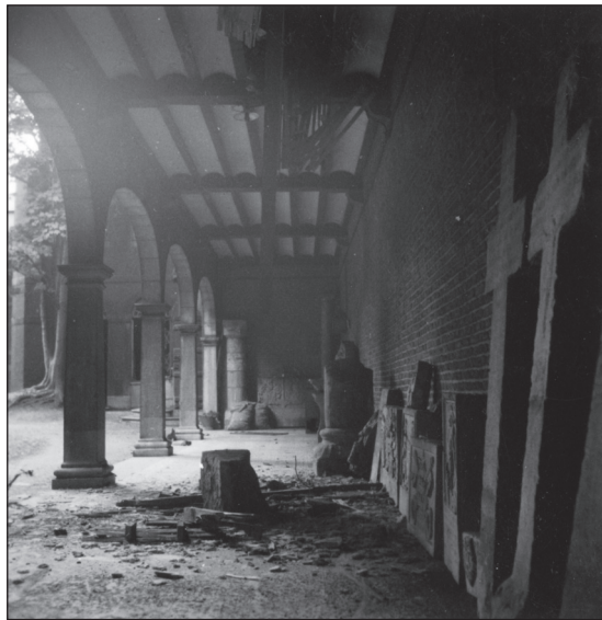
Fig. 10 – La galerie ouest (aujourd’hui disparue) éventrée par la chute d’un bloc de pierre détaché du pont Maghin, dynamité en mai 1940 pour freiner l’avancée des Allemands. © Ville de Liège, Grand Curtius – cliché H. van Heule.
