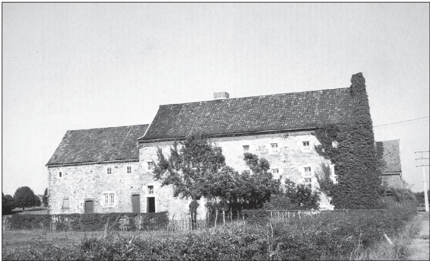
Fig. 5 – Ferme herbagère au pays de Dalhem, à Aubel, au lieu-dit Gorhez, 346 (ferme de Langstraat), XVII e siècle. D'après Le patrimoine monumental de la Belgique – Wallonie , vol. 12 1 , Liège, 1984, p. 91.
