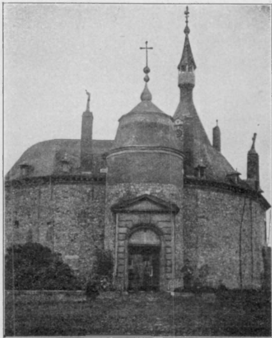
Entrée du château de Waroux.
